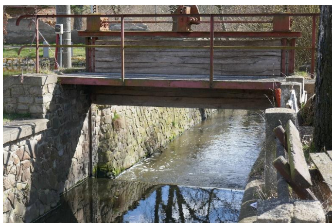
Stavidlo návodní strana
