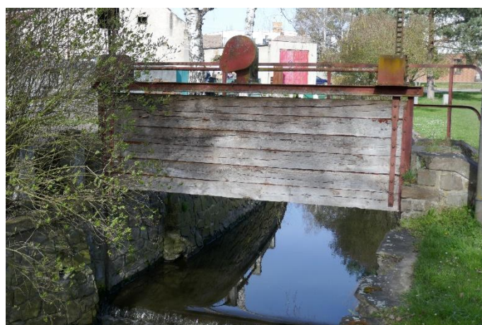
Stavidlo povodní strana
