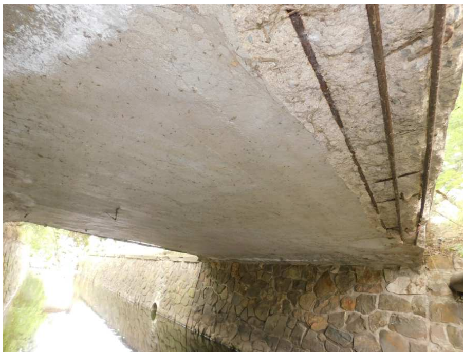
Obr. 2.3 – Spodní líc nosné konstrukce
