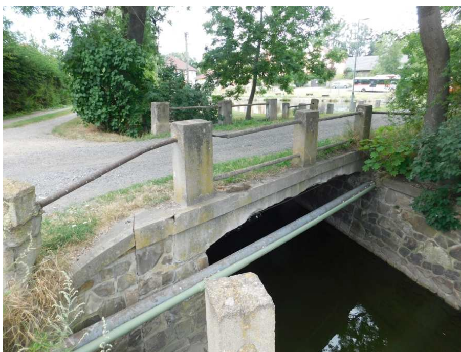
Obr. 2.2 – Pohled na most z levé strany
